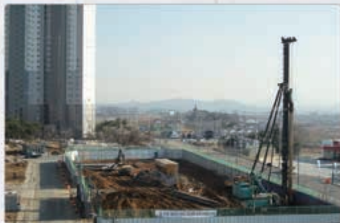
[ 안중농협 본점청사 공사현황 ]
